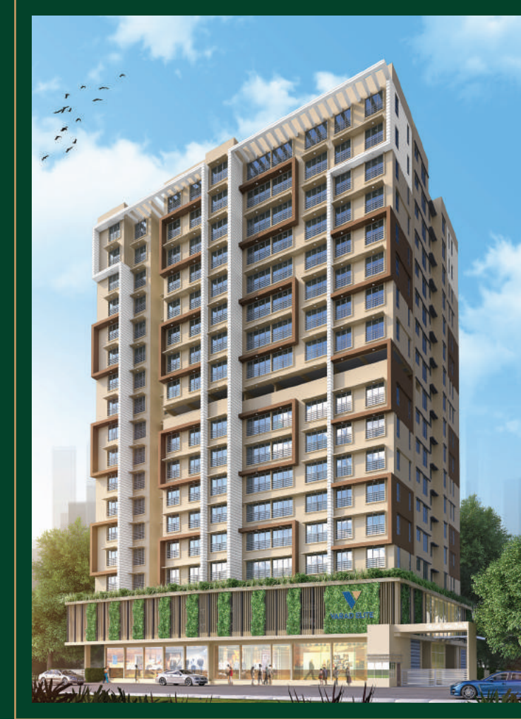
Varad Height Tilak Nagar, Chembur.
